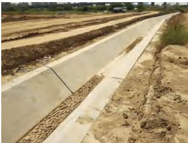
场内道路梯形排水沟
