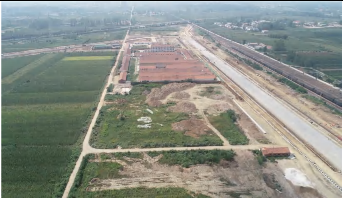
铁路连接线及新建集装箱区现状（2019.9）
