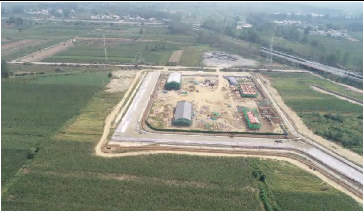
项目区附属工程区情况（2019.9）
