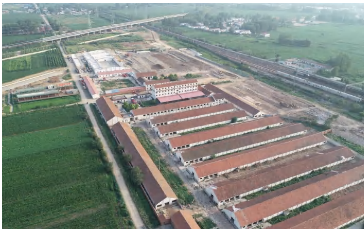
铁路连接线及新建集装箱区现状（2019.6）
