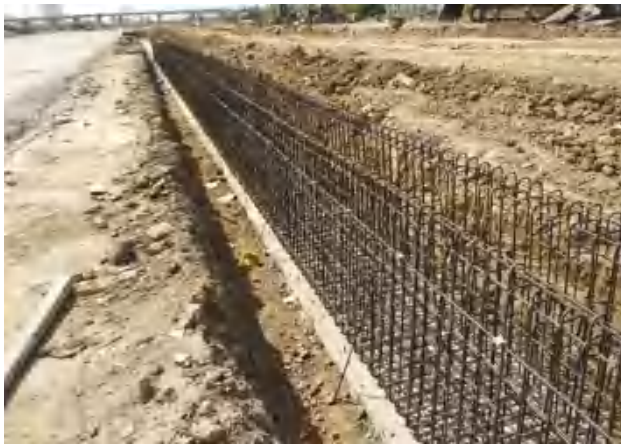
项目区矩形排水沟施工
