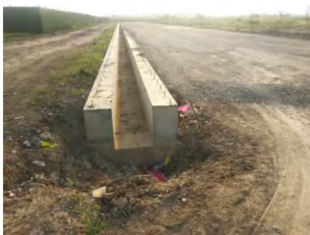
场内道路梯形排水沟
