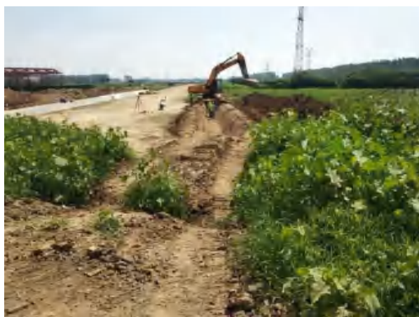
场内道路梯形排水沟开挖
